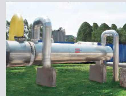
50000Nm 3 /h U型管板LNG气化器 50000Nm 3 /h U tube-plate LNG Vaporizer
