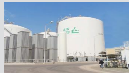
AP沙特吉赞项目15x8000Nm 3 /h空温式气化器现场 15x8000Nm 3 /h Ambient Air Vaporizer for AP Saudi Arabia Jazan Project
