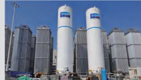
广钢气体16x10000Nm 3 /h空温气化器项目现场 G-gas 16x10000Nm 3 /h Ambient Vaporizer Project Site
