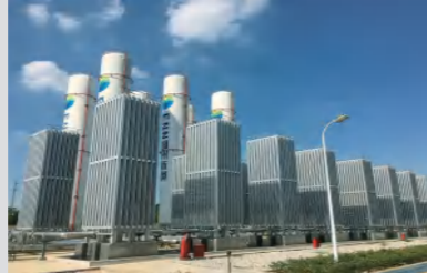
湖州新奥LNG气化站现场 Jobsite of Huzhou ENN LNG Regasification Station
