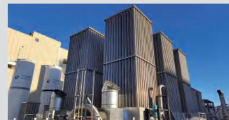
林德气体10x12000Nm 3 /h空温气化器项目现场 Linde 10x12000Nm 3 /h Ambient Vaporizer Project Site
